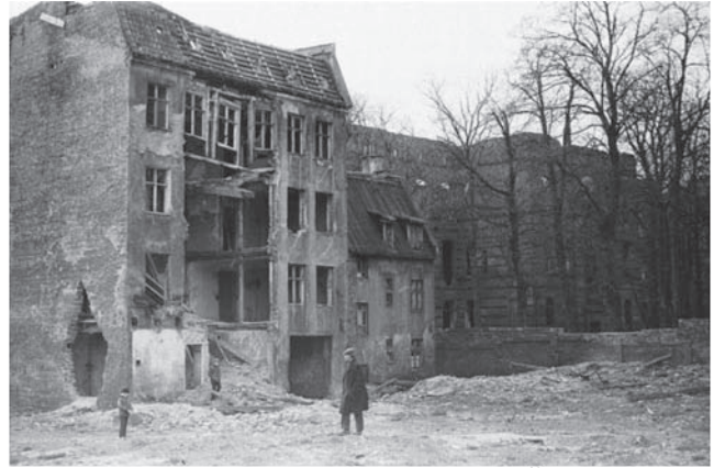
Рис. 5. Бывший II лечебный корпус гарнизонного лазарета «Йорк» и немецкий жилой дом, не сохранившиеся до наших дней, со стороны современной улицы Фрунзе г. Калининграда. 1975 г. Источник: pastvu.com
