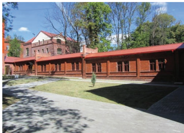
Рис. 10. Современный вид крытой межкорпусной галереи, соединяющей хозяйственный и I, II и III лечебные корпуса гарнизонного лазарета «Йорк». За галереей видно новое здание администрации Инфекционной больницы, построенное на месте бывшего II корпуса гарнизонного лазарета «Йорк». 2020 г. [14]
