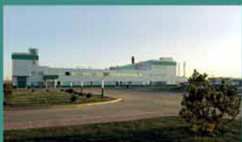
Завод по производству готовых лекарственных форм г. Ярославль
